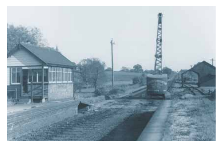
Signal Box at Bangor on Dee with demolition work commencing in 1963 Blwch signalau ym Mangor Is-coed a'r gwaith dymchwel a ddechreuodd yn 1963
